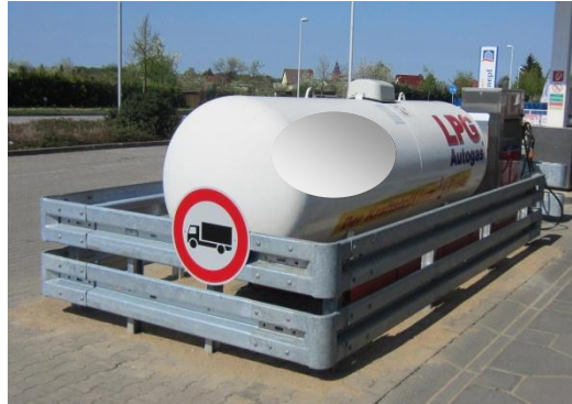
Abbildung 10: angepasster Anfahrerschutz, Quelle: LAGuS M-V
