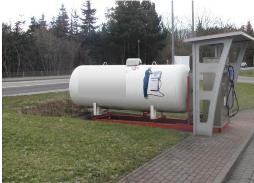
Abbildung 8: nicht angepasster Anfahrsschutz Quelle Abbildungen 8 und 9: LAGuS M-V
