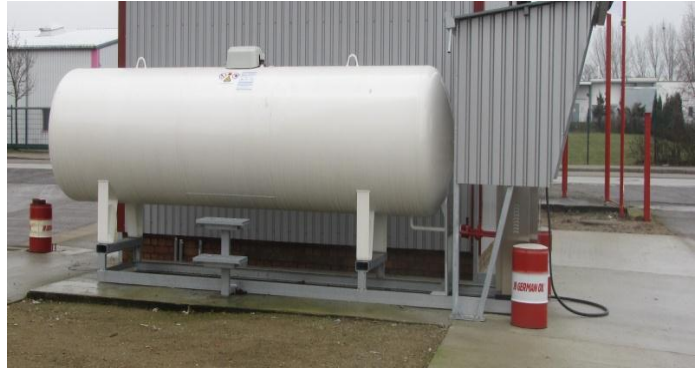
Abbildung 9: nicht angepasster Anfahrsschutz
