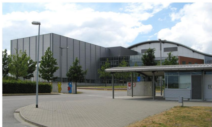
Abbildung 17: Gebäudekomplex des Stellarators Wendelstein 7-X in Greifswald, links die Torushalle Quelle: www.sciencenet-mv.de , Bernd vdB unter CC-Lizenz
