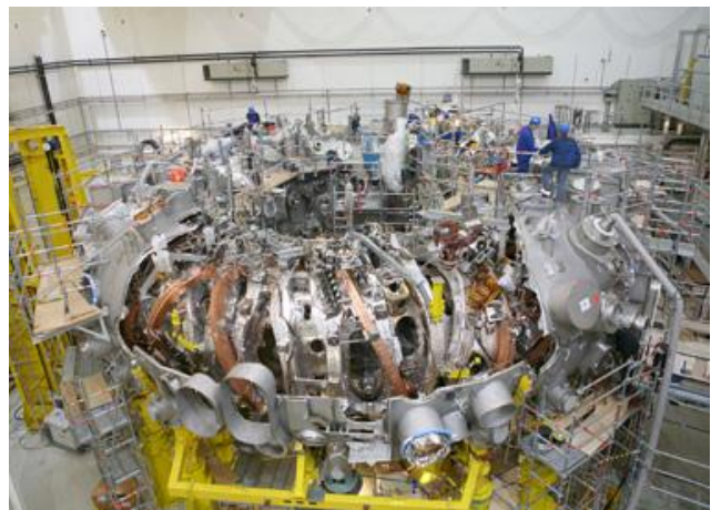
Abbildung 18: W 7-X-Basismaschine vor Montage des letzten Kryostat-Teils, Quelle: IPP, Anja Richter-Ullmann
