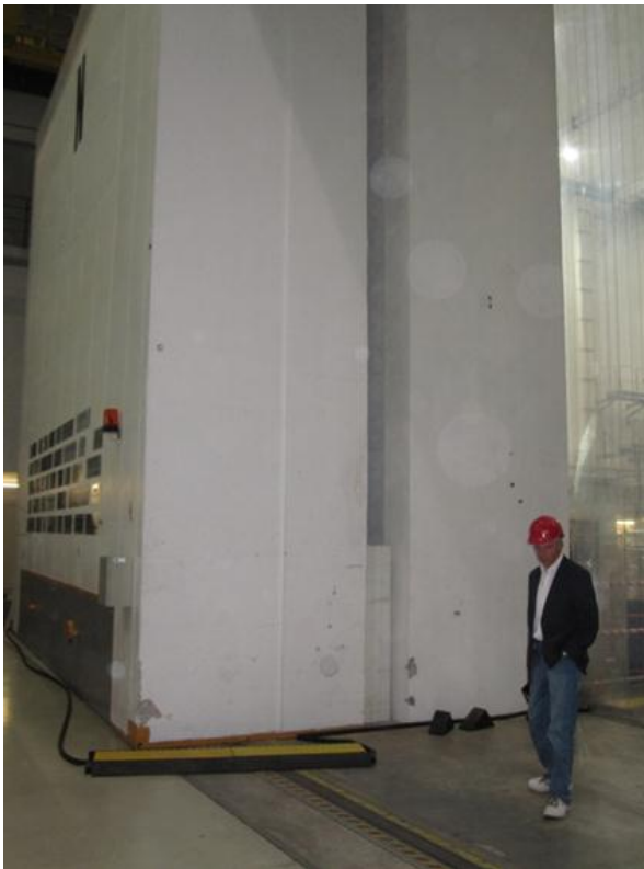
Abbildung 6: Strahlenschutztor, Quelle: LAGuS M-V
