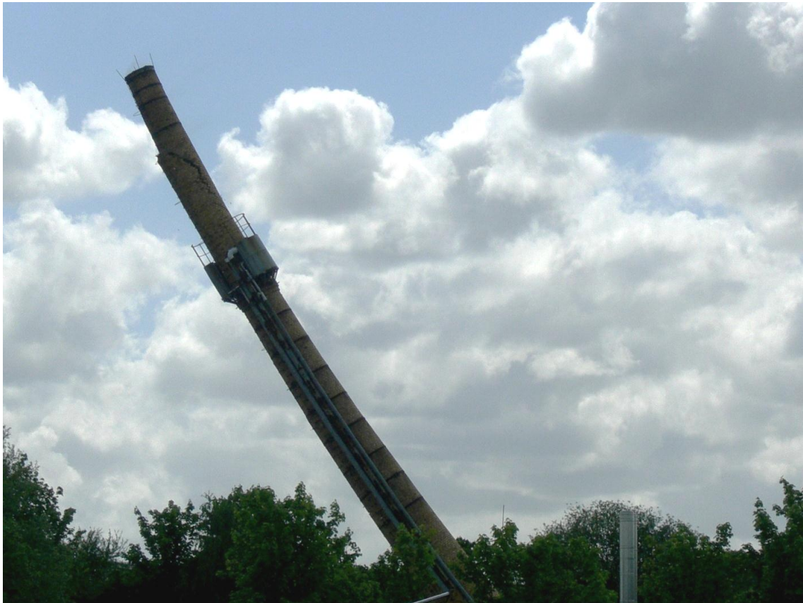
Abbildung: 22: Schornstein fallend, nach der Sprengung, Quelle: LAGuS M-V
