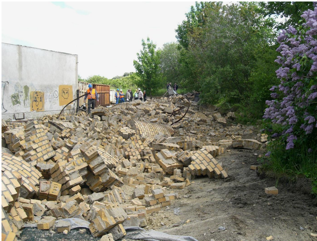
Abbildung: 23: Schornstein liegend, nach der Sprengung; Quelle: LAGuS M-V
