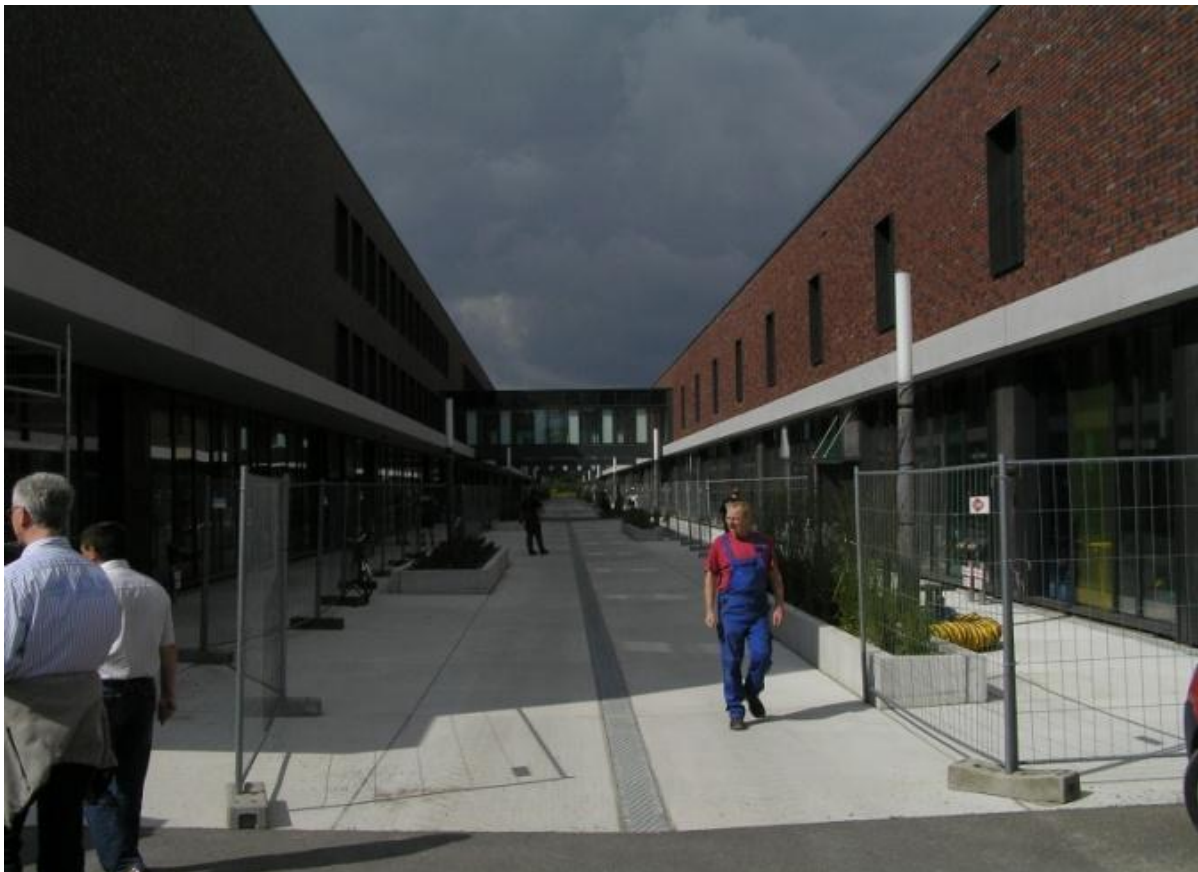
Abbildung 23: FLI Riems - Innere Straße, kurz vor der Fertigstellung, Quelle: LAGuS M-V
