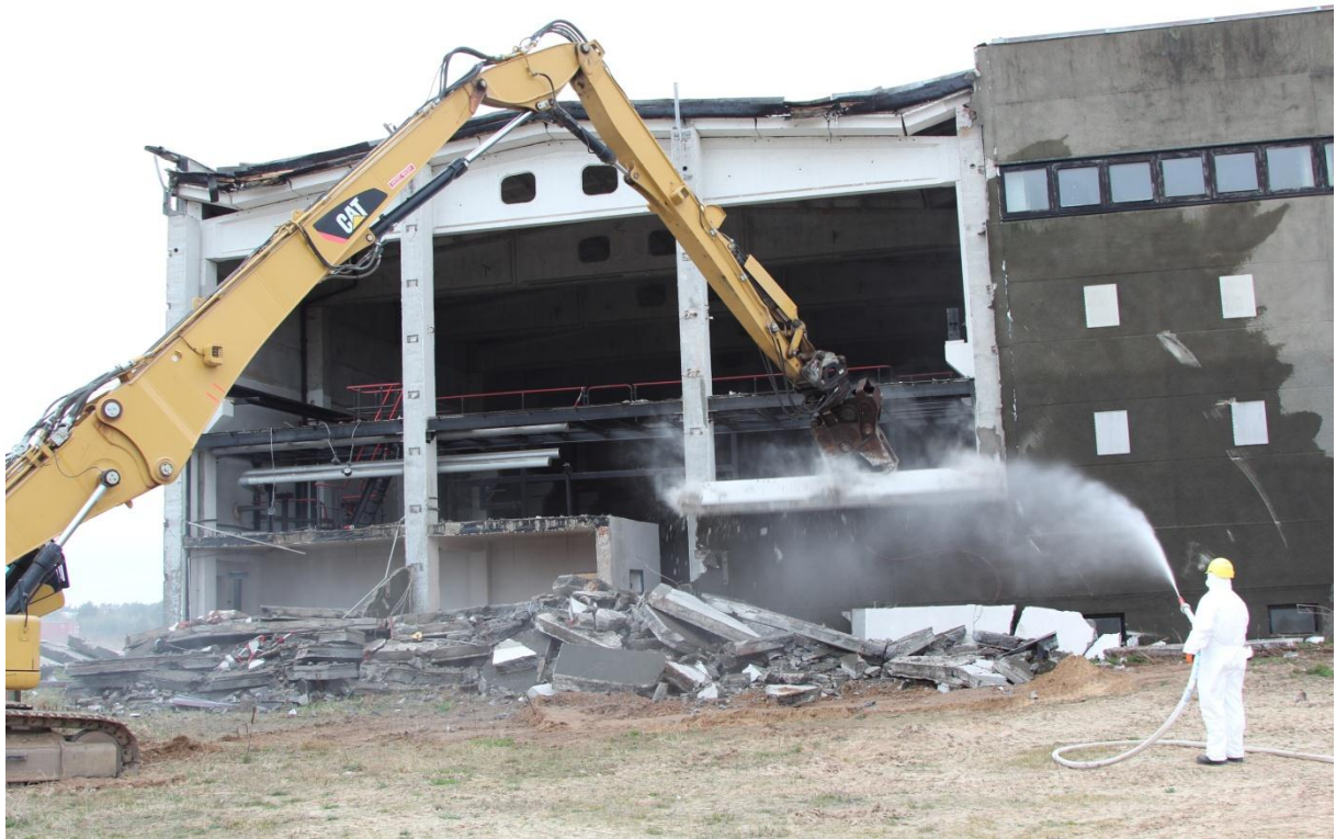
Abbildung 21: Demontage der Fassadenplatten mittels Bagger unter Einsatz von Sprühgerät, Quelle: LAGuS M-V
