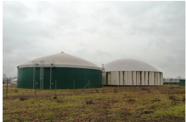
Abbildung 18: Fermenter mit Gasspeicher
