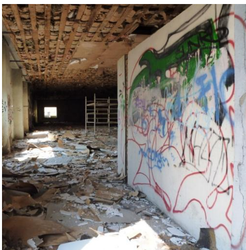
Abbildungen 19 und 20: unsachgemäß abgebrochene krebserzeugende Gefahrstoffe Quelle: Abbildungen 19 und 20: LAGuS
