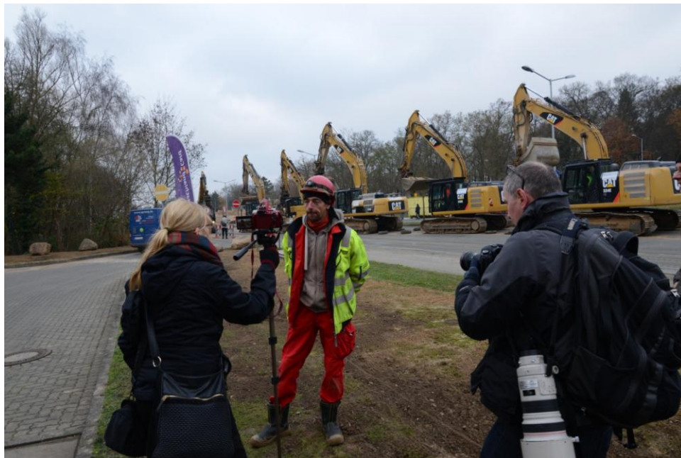
Abbildung 22: Der Sprengverantwortliche und Baufahrzeuge, Quelle: LAGuS
