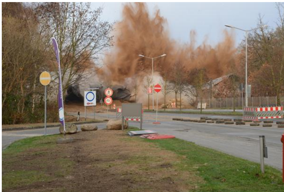
Abbildung 21: kontrollierte Sprengung der Brücke, Quelle: LAGuS
