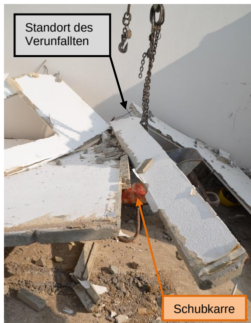
Abbildung 8: umgekippte Wandplatte, Quelle: LAGuS
