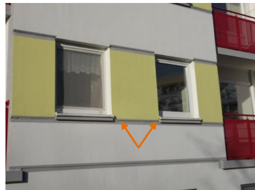
Abbildung 12: Fassade saniert, Morinolfugen überstrichen
