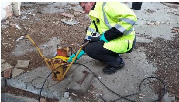
Abbildung 21: messtechnische Vor-Ort-Untersuchung aufgefundener Strahlenschutzbehälter Quelle Abbildungen 20+21: LAGuS
