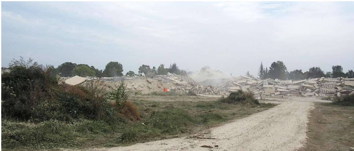
Abbildung 25: ehemaliges Müritz-Hotel nach der Sprengung, Quelle: LAGuS
