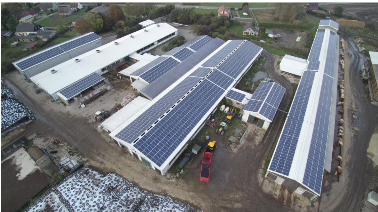
Abbildung 23: Milchhof nach der Dachsanierung, Quelle: LAGuS
