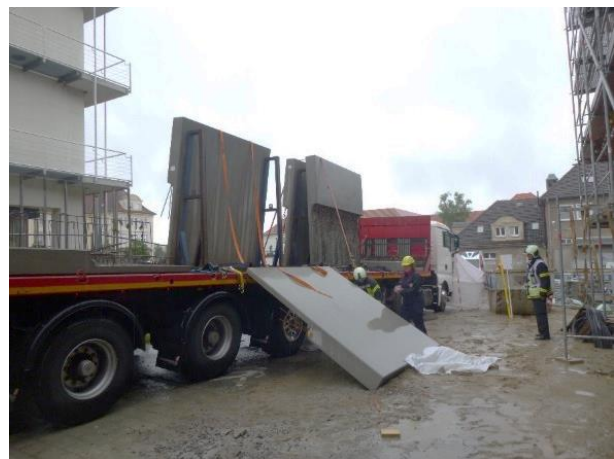
Abbildung 15: umgestürzter Deckel des Tauchbeckens Quelle: LAGuS
