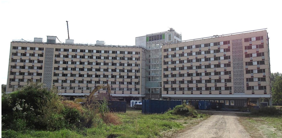
Abbildung 24: ehemaliges Müritz-Hotel vor der Sprengung, Quelle: LAGuS
