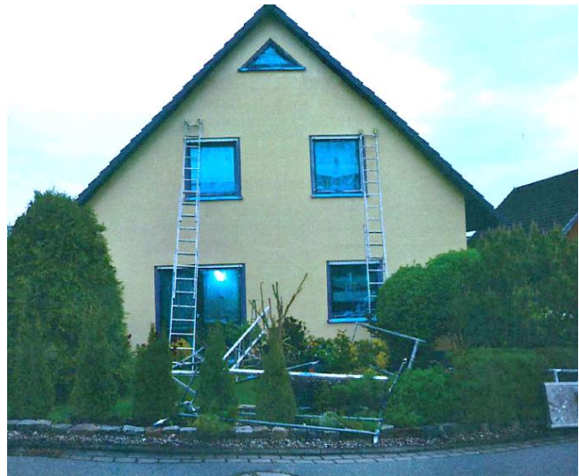
Abbildung 10: umgestürztes Gerüst, Quelle: LAGuS
