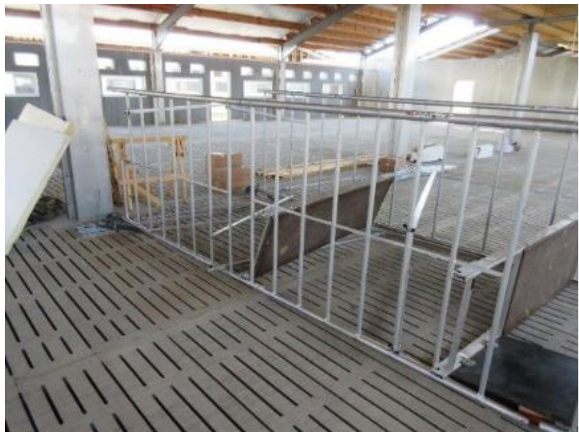
Abbildung 11: umgekippte Arbeitsbühne auf dem Spaltendoden Quelle: LAGuS
