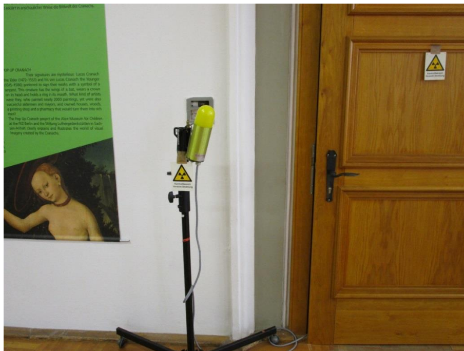
Abbildung 30: Kennzeichnung des Kontrollbereiches mittels Warnschild und Blinklampe Quelle LAGuS
