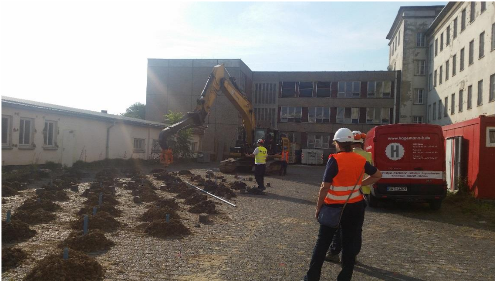
Abbildung 6: Bohrarbeiten auf dem Hinterhof, Quelle: LAGuS
