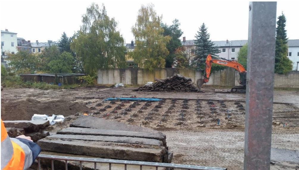
Abbildung 7: Fertiges Bohrraster für die Sondierung, Quelle: LAGuS
