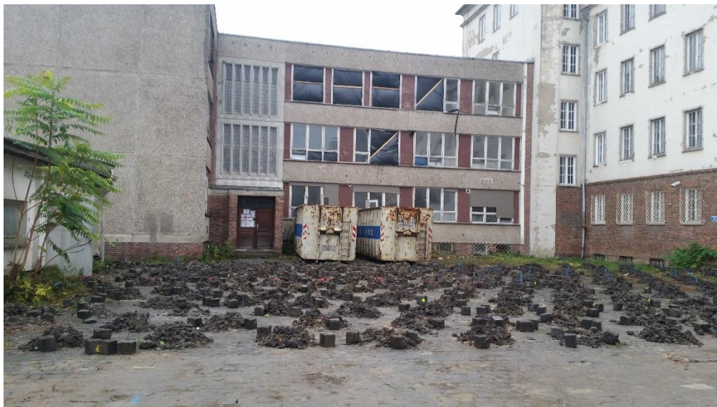
Abbildung 8: Gebäude bei laufenden Asbestsanierungsarbeiten Quelle: LAGuS
