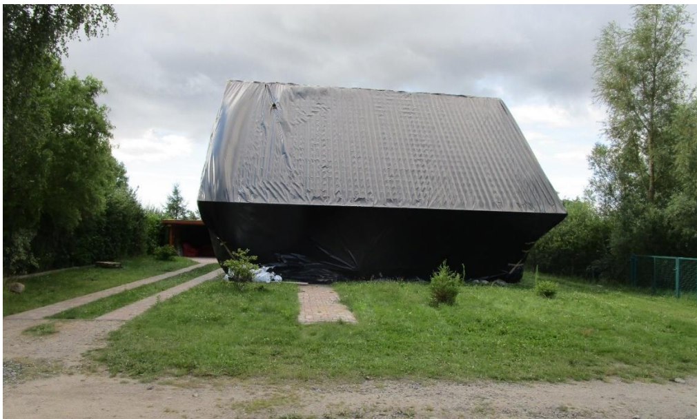
Abbildung 17: In gasdichter Folie eingehülltes Haus, vor der Begasung, Quelle: LAGuS
