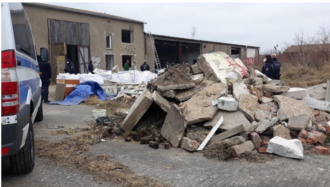
Abbildung 16: Gemeinsame Kontrolle einer Baustelle bei Rostock, Quelle: LAGuS
