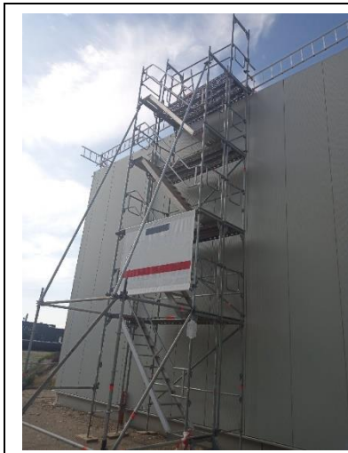
Abbildung 10: Treppenturm als Aufstieg zur Dachfläche
