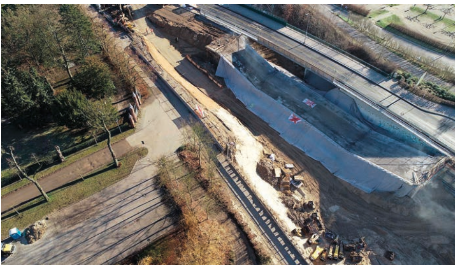
Niedergelegte Nordbrücke nach erfolgreicher Sprengung
