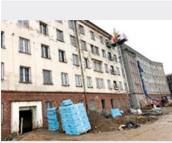
Fortgang der Kernsanierung
